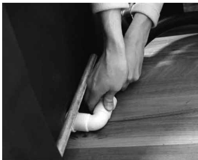
2. Démontage du tuyau d'évacuation
