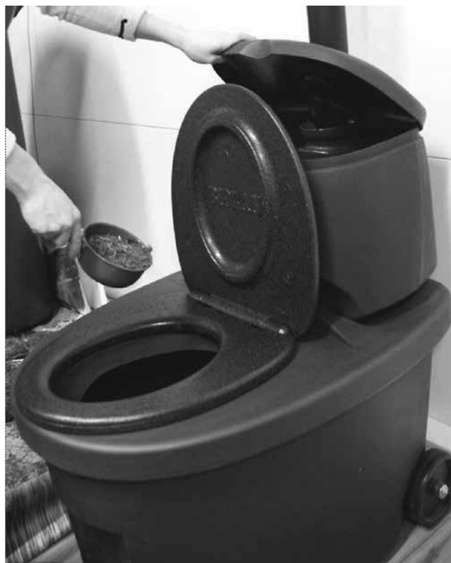
1. Dodawanie materiału spęczniającego
