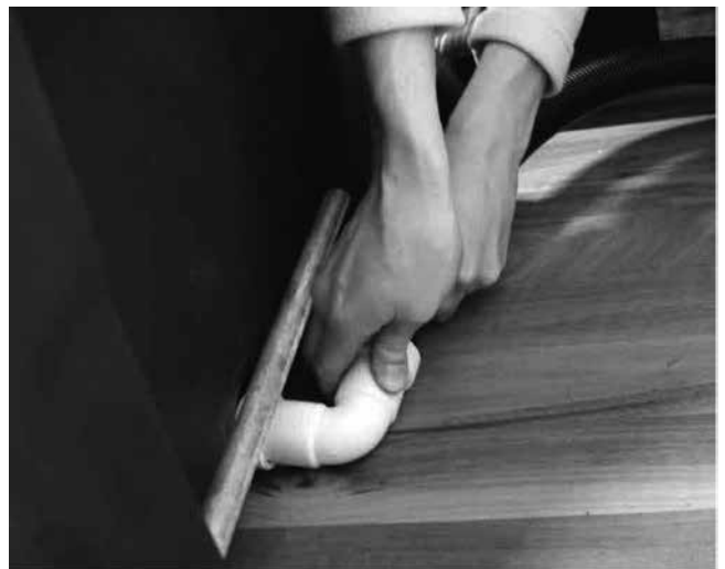
2. Urkoppling av dräneringsslangen.
